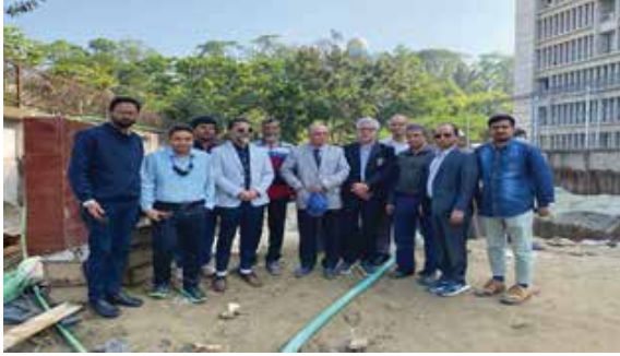
আইইবি, কক্সবাজার উপকেন্দ্রের বহুতল ভবন নির্মাণে ঢালাইয়ের কাজ উদ্বোধন।
